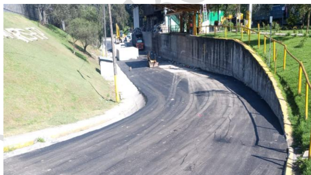
Ilustración 1. Rehabilitación de Vías internas ETN
