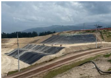
Ilustración 6. Instalación de geomembrana
