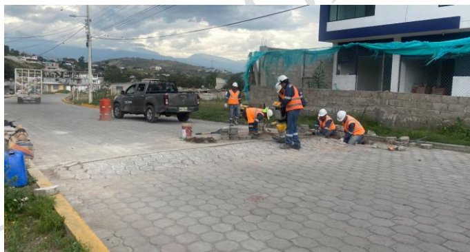
Ilustración 8 Construcción de Vías RS “El Inga”
