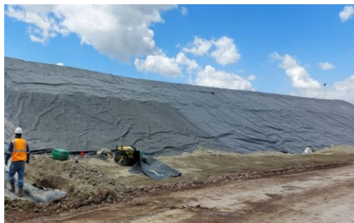
Ilustración 6. Instalación de geomembrana
