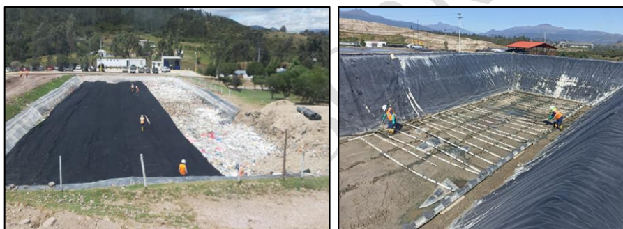
Ilustración 13. Vaciado de las piscinas Nro. 8 y 10
