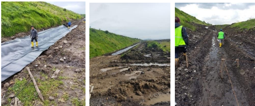
Ilustración 16. Construcción del sistema de drenaje
