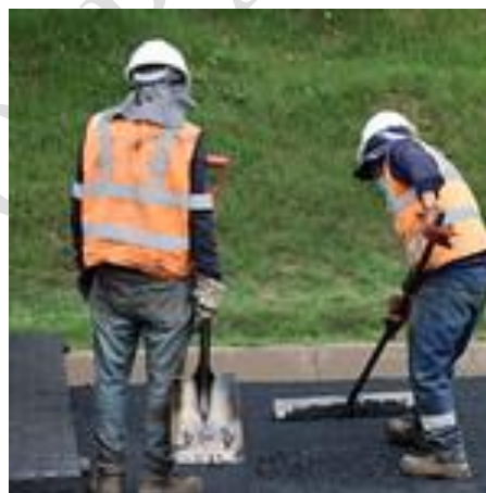
Ilustración 4. Imprimación asfáltica ETN
