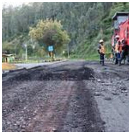
Ilustración 4. Imprimación asfáltica ETN
